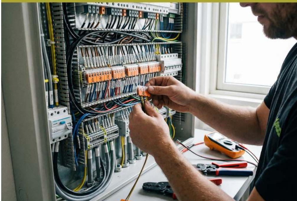
Utilisation de connecteurs Wago pour une liaison rapide et sécurisée
